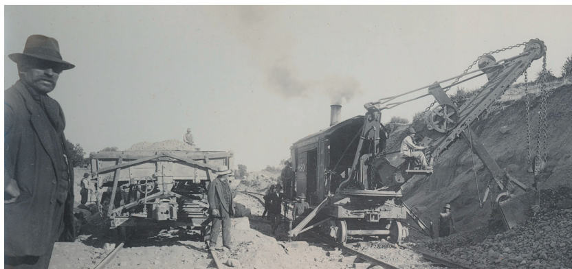
Maquinaria y obreros en la construcción del Ferrocarril Confluencia-Penco, 1916.
