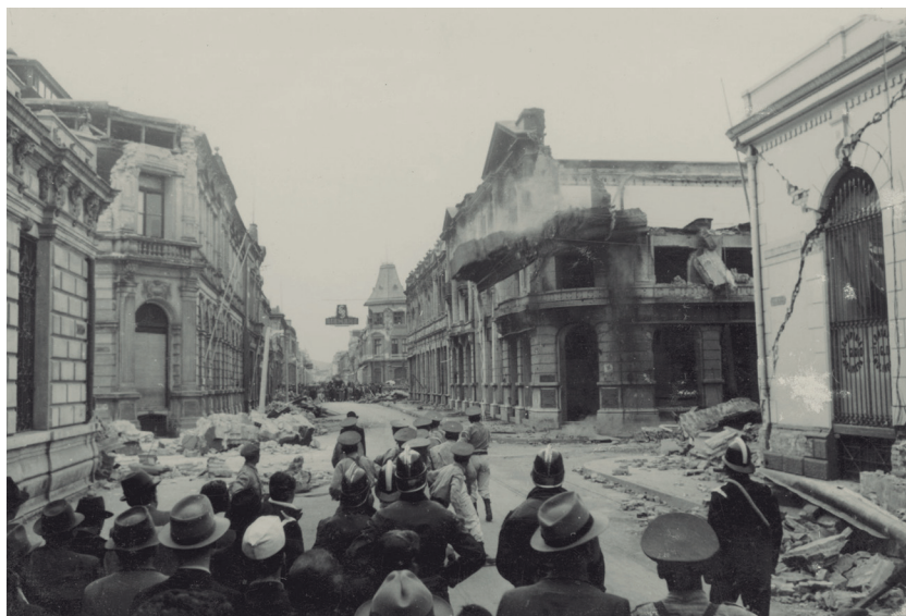
Calle Barros Arana, en Concepción, con la Casa Gleisner al fondo, mostrando los efectos del sismo y de los incendios que le siguieron.
