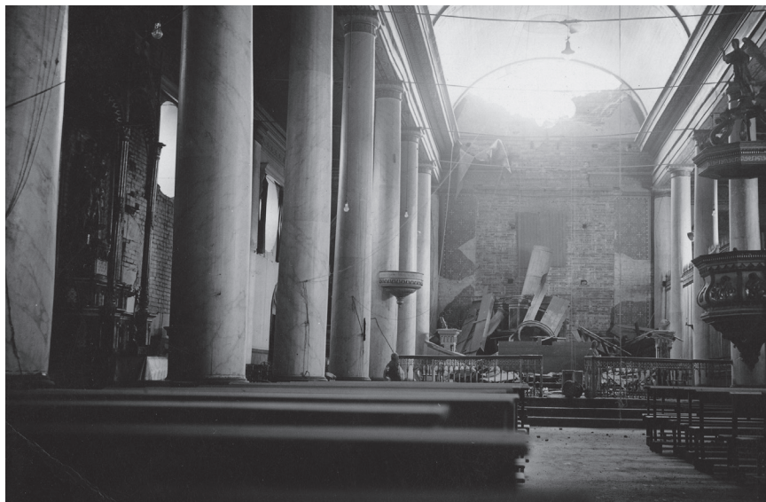
Interior del templo después del terremoto de 1939. (Fondo Archivo Fotográfico Universidad de Concepción)
