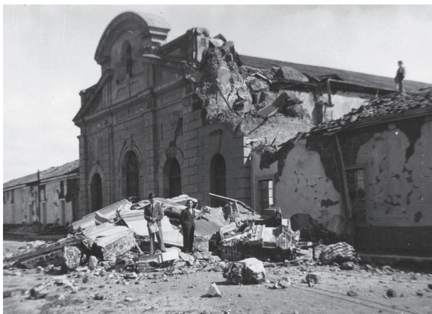
Demolición de la torre campanario después del terremoto de 1939. (Fondo Archivo Fotográfico Universidad de Concepción)
