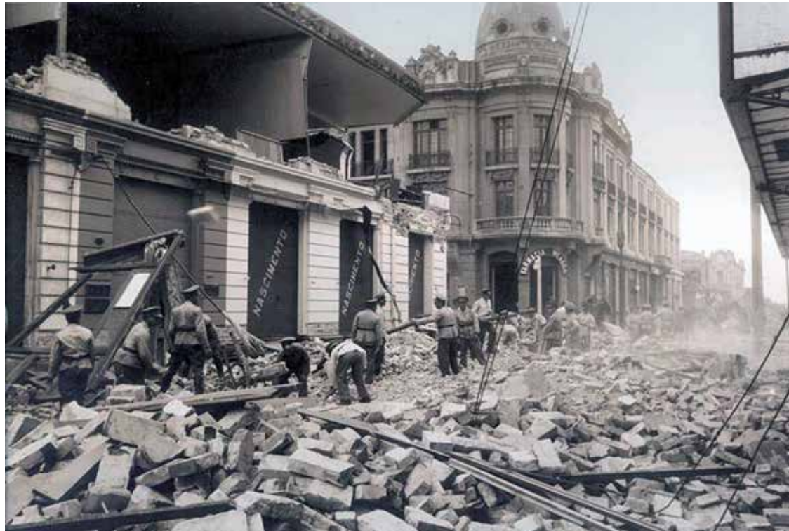
Estragos producidos en el centro de la ciudad de Concepción, por el terremoto del 24 de enero de 1939.
